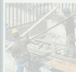
Un cantiere (archivio)
